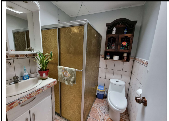
Fotografía N°8 Baño completo con enchape cerámico a media altura y mueble fijo de lavatorio.
