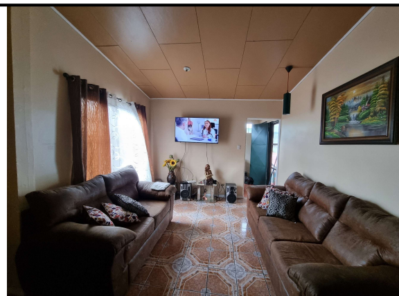
Fotografía N°5 Sala con piso cerámico y cielorraso de fibrolit.
