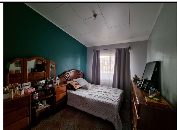
Fotografía N°9 Dormitorio #2 con piso cerámico y cielorraso de fibrolit.
