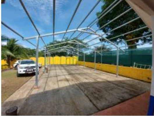
Imagen 1. Losa con estructura metálica
